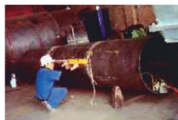
Overhaul de Calderas Acuotubulares
